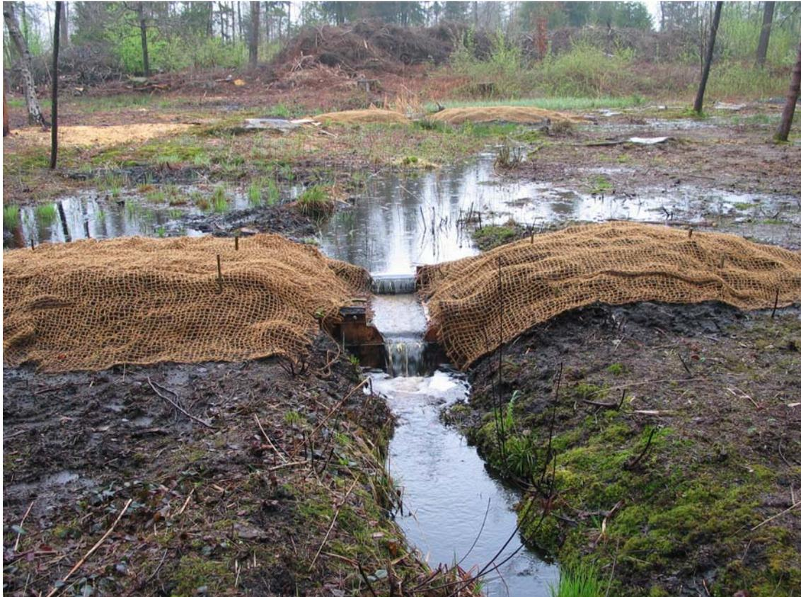
Beispiel eines Grabenaufstaus mit Verfüllung
