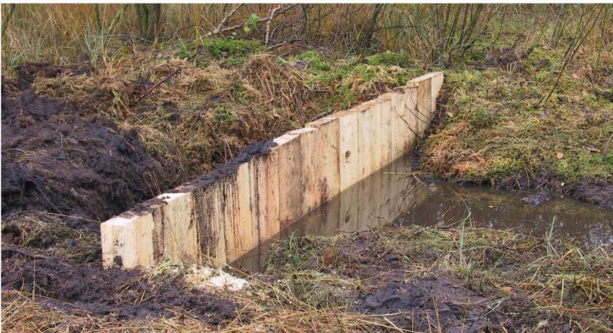
Spundwände zum Grabenaufstau wurden im Kanton Zürich am häufigsten eingesetzt.
