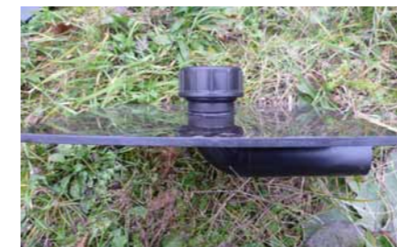
Dank dem eingebauten Auslass kann das Gewässer entleert werden. Der Auslauf wird am tiefsten Punkt des Gewässers auf dem Geotextil angebracht. Die EPDM-Abdichtungsfolie wird darübergelegt und mit der Platte des Auslaufs verschweisst. Der von Kies und Steinblöcken umgebene Betonschacht schützt den Grundablass.
