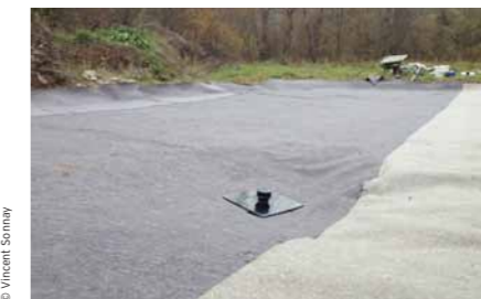
Dank dem eingebauten Auslass kann das Gewässer entleert werden. Der Auslauf wird am tiefsten Punkt des Gewässers auf dem Geotextil angebracht. Die EPDM-Abdichtungsfolie wird darübergelegt und mit der Platte des Auslaufs verschweisst. Der von Kies und Steinblöcken umgebene Betonschacht schützt den Grundablass.
