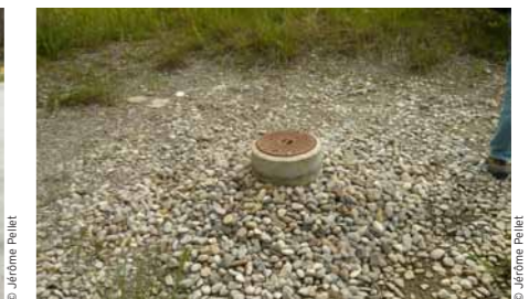
Dank dem eingebauten Auslass kann das Gewässer entleert werden. Der Auslauf wird am tiefsten Punkt des Gewässers auf dem Geotextil angebracht. Die EPDM-Abdichtungsfolie wird darübergelegt und mit der Platte des Auslaufs verschweisst. Der von Kies und Steinblöcken umgebene Betonschacht schützt den Grundablass.
