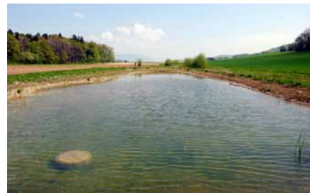
Illustration 2. Kommen keine anderen Bautypen infrage, ist die künstliche Abdichtung eine gute Lösung zur Schaffung neuer Temporärgewässer. Die Abdichtung besteht aus mehreren Schichten, die auch unterschiedlich dick sind.
