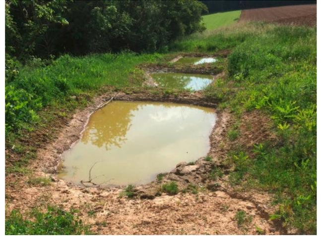
**Abdichtung bestehender, feuchter bis vernässter Mulden und Gräben** mit Vibroplatte, Ramax, Baggerschaufel. Flache Umgebung gestalten ohne Wälle, sodass alles Wasser aus der Umgebung zulaufen kann. In Gräben untereinander gestaffelte Teilgewässer (Tümpelkette) erstellen mit Überlauf in unproblematische Flächen (Hecken, Säume, etc.).
