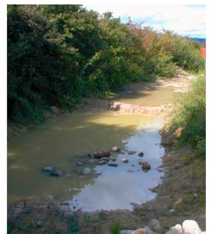
**Permanent Wasser führendes Gewässer mit Stabilit-Kalkpackung.** Vorbereitung und Einbau von kalkstabilisiertem Material.
