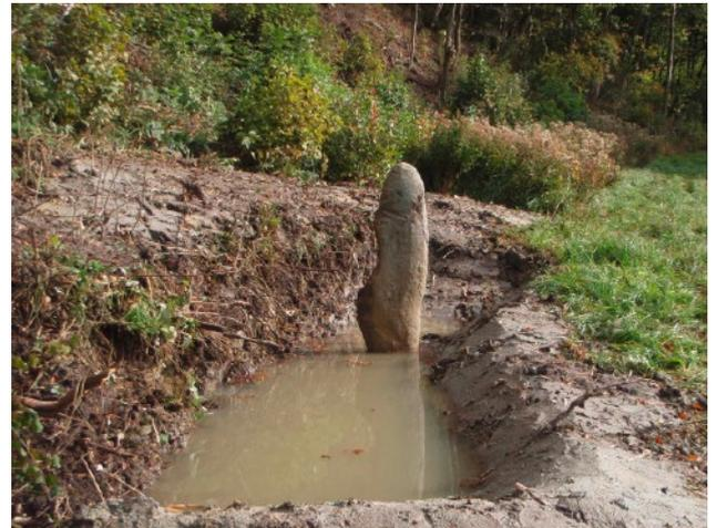
**Fassen von Hangdruck durch Materialaushub** mit Frontschaufel, Kleinbagger, etc. Aushub beschränken auf Bereich mit lehmigem /dichtem Untergrund.
