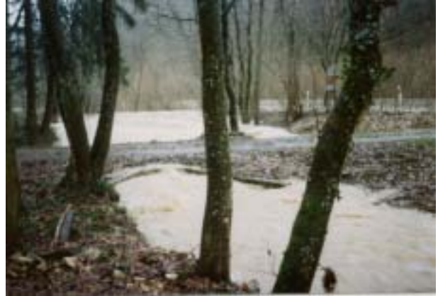
Abbildung 31: Geschiebesammler am Seegraben während des Hochwassers vom 25./26. Januar 1995. Quelle: ABTEILUNG GEWÄSSER (bis 2001b).
