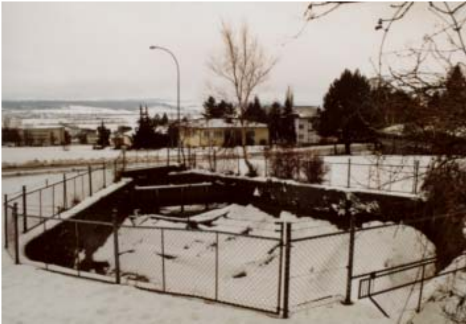
Abbildung 36: Geschiebesammler als Tierfalle – Geschiebesammler am Wissbächli bei Grenchen.
