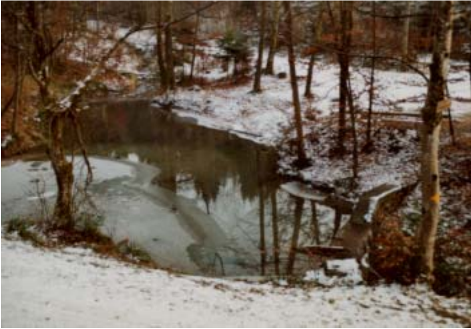
Abbildung 38: Naturnah gestalteter Geschiebesammler, aber mit grosser Sperre als Hindernis für wandernde Tierarten am Hinteren Chrebsbach am Eschenberg bei Winterthur.
