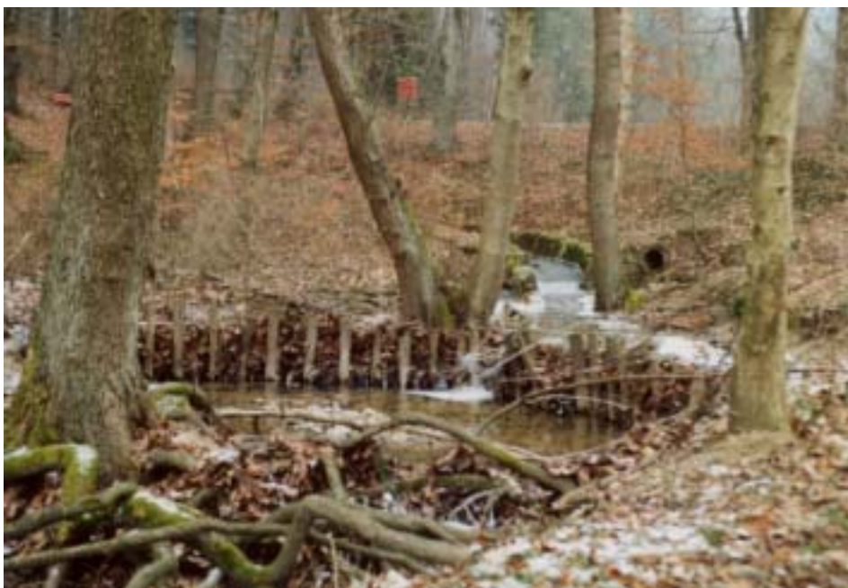
Abbildung 41: Aufweitung mit Rechen aus eingeschlagenen Holzpfählen am Lindberg bei Winterthur.
