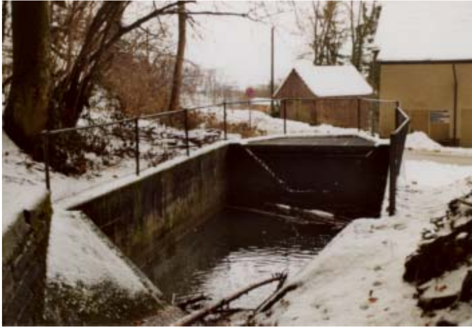
Abbildung 37: Geschiebesammler am Witibach bei Grenchen: Wanderhindernis und Tierfalle zugleich.
