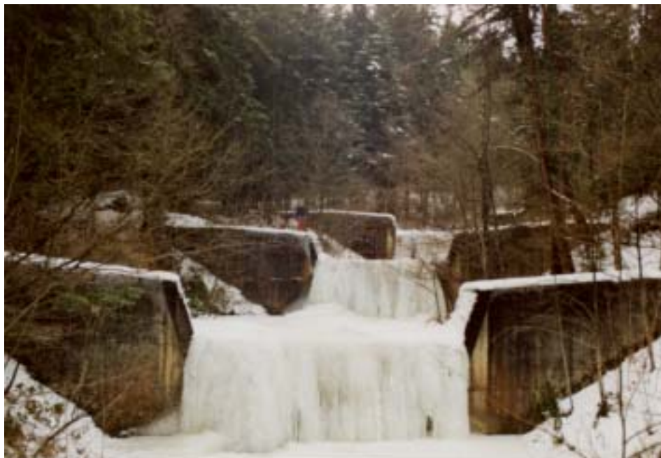
Abbildung 48: Vollständiger Sperrenverbau auf 1.5 km Länge am Widenbach bei Altstätten, als Beispiel für grosse Wanderhindernisse.
