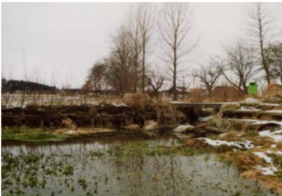
Abbildung 44: Naturnaher Geschiebesammler am Dorfbach in Hindelbank; Blick auf Abschlussbauwerk und Flechtzaun aus Weiden.
