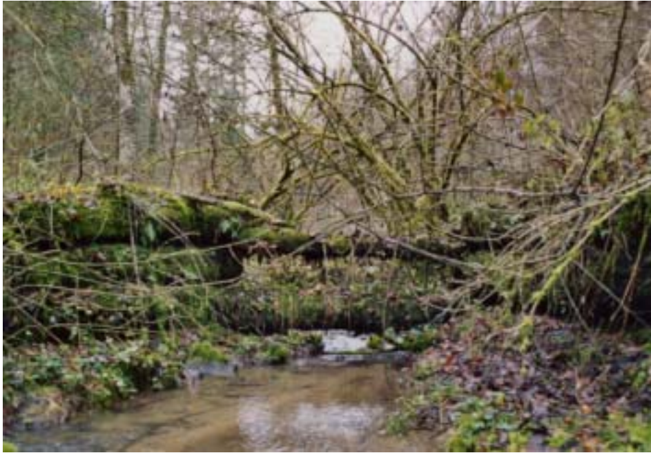
Abbildung 16: Geschiebesammler 3.11 am Stutzgraben mit temporärer Ablagerung. Als Abschlussbauwerk dient eine Balkensperre.
