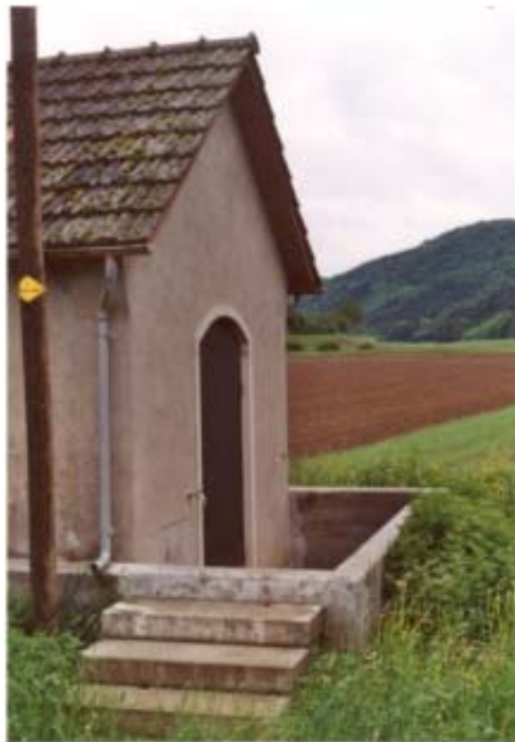
Abbildung 5: Grundwasserpumpwerk Osterfingen als Beispiel für Objektschutz. Die kleine Mauer um das Gebäude schützt vor Überschwemmungen.
